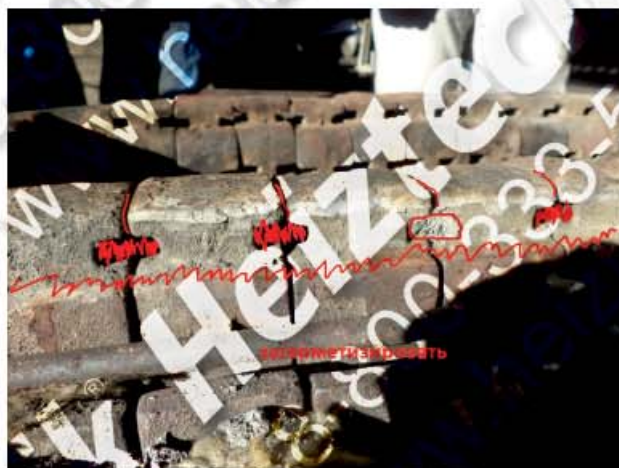
Герметизация гогорелки ЕКОМАХ
